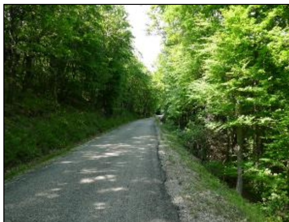
Route d'Aleyrac (RD 809) au niveau du Ravin de Gurnier
