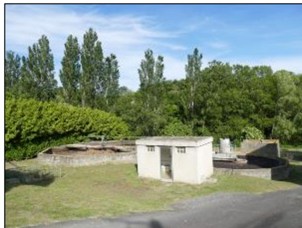
Station d'épuration – route de Grillon
