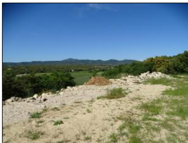
Remblai – chemin de Ventebrin
