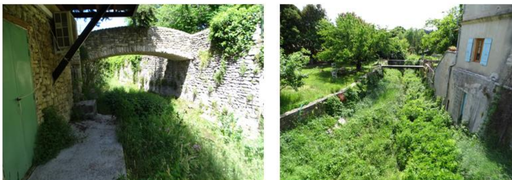
La Riaille dans la traversée du village de Taulignan – Terrasses et ouvrages de franchissement
