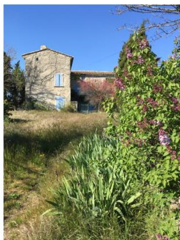
Le mas Organisation des volumes en L (protection par rapport au vent dominant) Hauteur à la rive du toit : env. 8 m. Largeur façade nord : env. 24 m.
