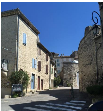
Pierres apparentes avec joints creux
