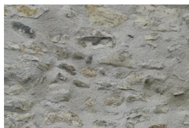
Joints à pierres vues
