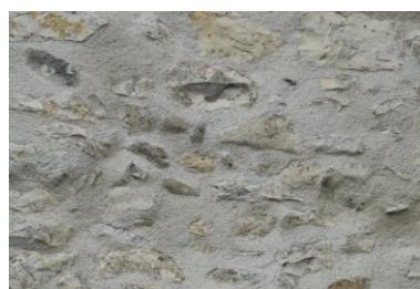
Joints à pierres vues
