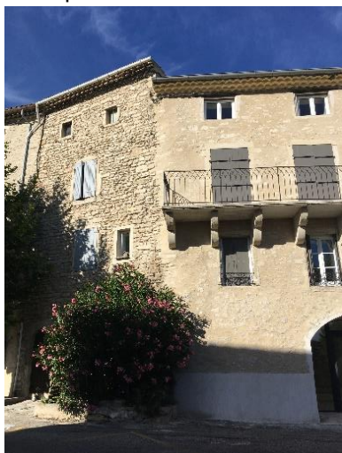
Pierres apparentes à gauche Enduits à pierres vues à droite
