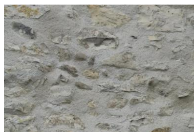
Joints à pierres vues
