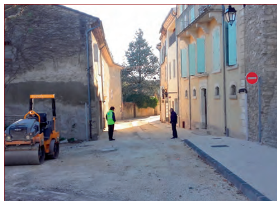
Réfection, aménagement et mise en accessibilité rue des Remparts
