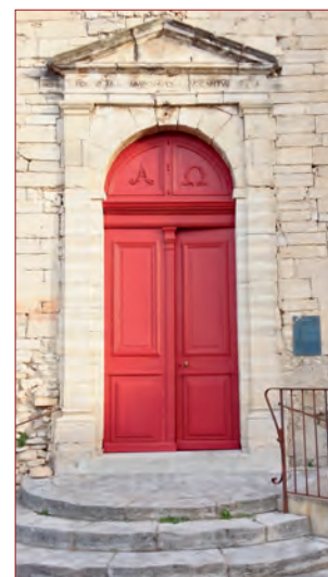
Mise en peinture Portes de l'Eglise
