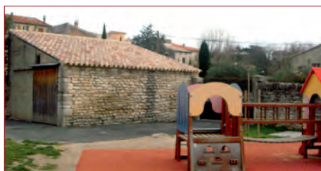
Dans la cour de l'école maternelle, réfection de la toiture du cabanon et du sol coulé sous la structure de jeux
