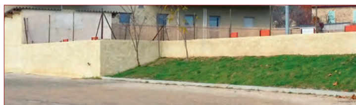
Réfection du mur de l'Amicale des Boules
