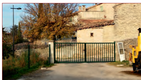
Rénovation grillage et portail des services techniques
