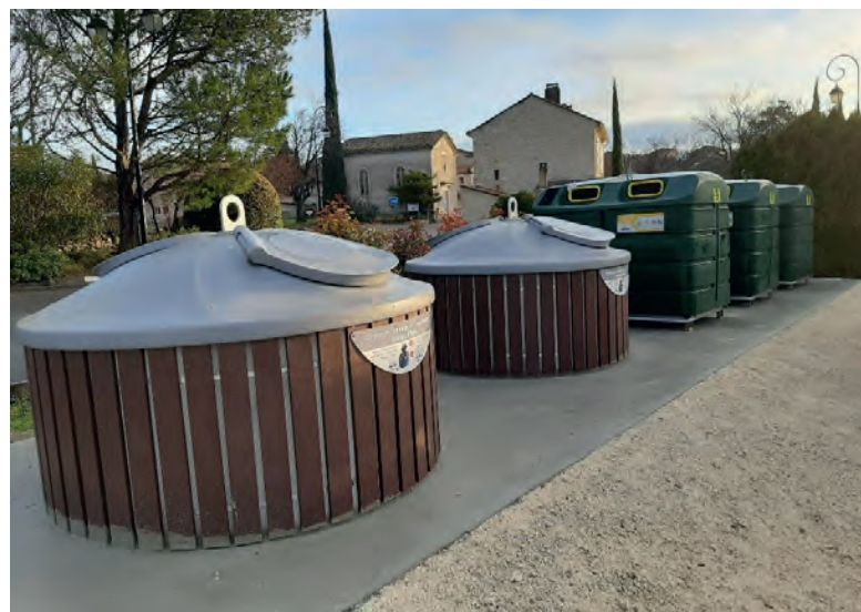
Source : Point d'apport volontaire de déchets - CCEPPG – Chantemerle Lès Grignan
