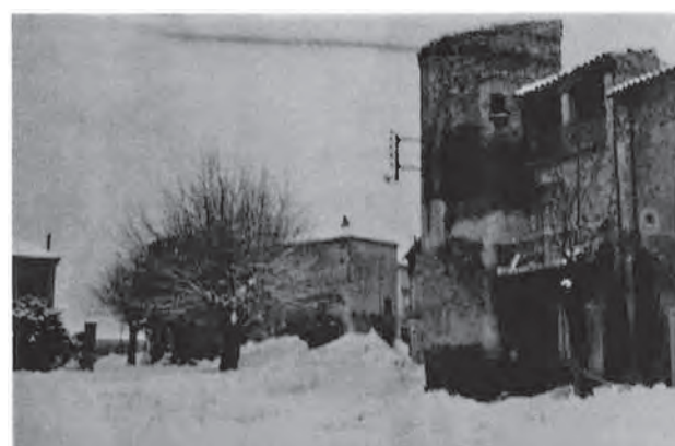
Grands Remparts, place du 11 Novembre
